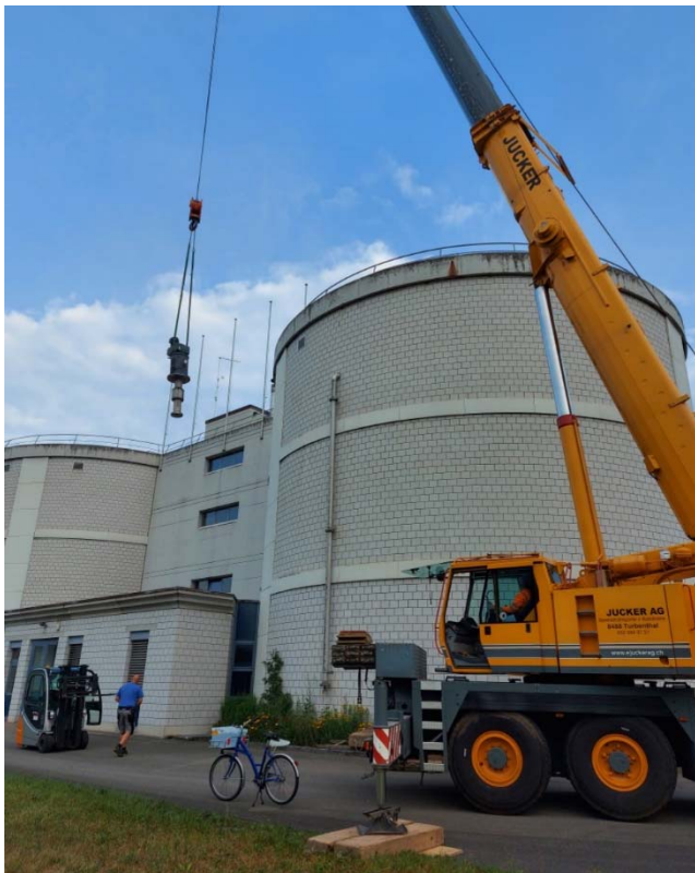
Pneukran zur Inspektion der Rührwerke im Faulturn
