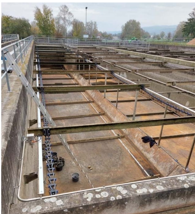
Sanierung Kettenräumer der Strasse 1 im Nachklärbecken
