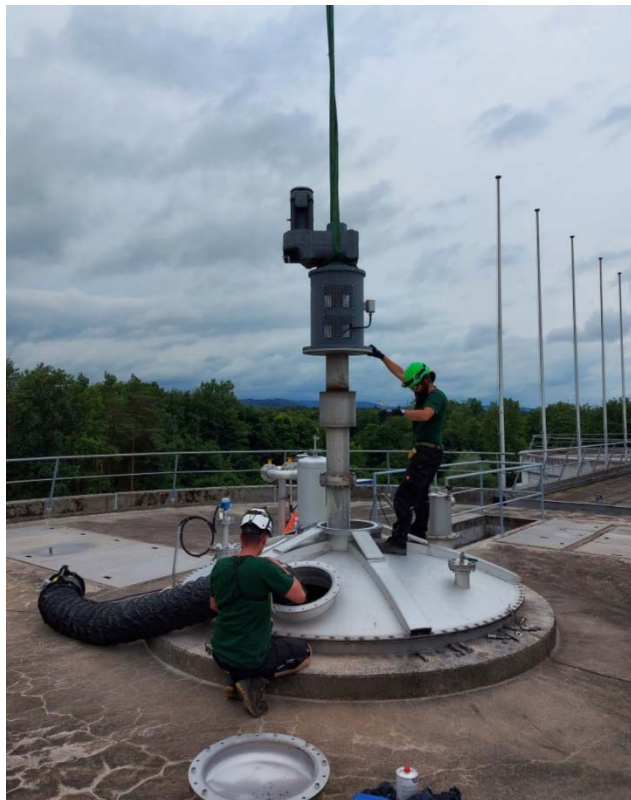
Arbeiten auf dem Faulturn zur Inspektion der Rührwerke
